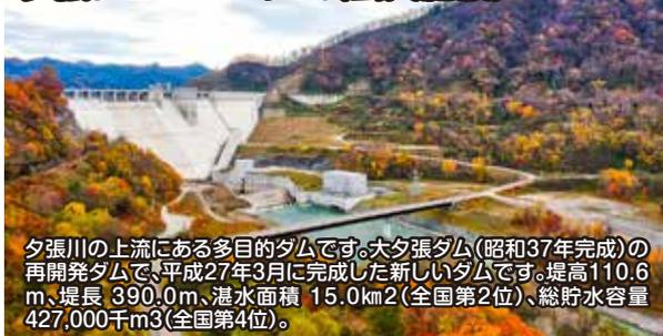
夕張川の支流にある多目的ダムです。夕張ダム(昭和37年完成)の再開発ダムで、平成27年3月に完成した新しいダムです。堤高110.6m、堤長390.0m、湛水面積15.0km<sup>2</sup>(全国第2位)、総貯水容量427,000千m<sup>3</sup>(全国第4位)。
